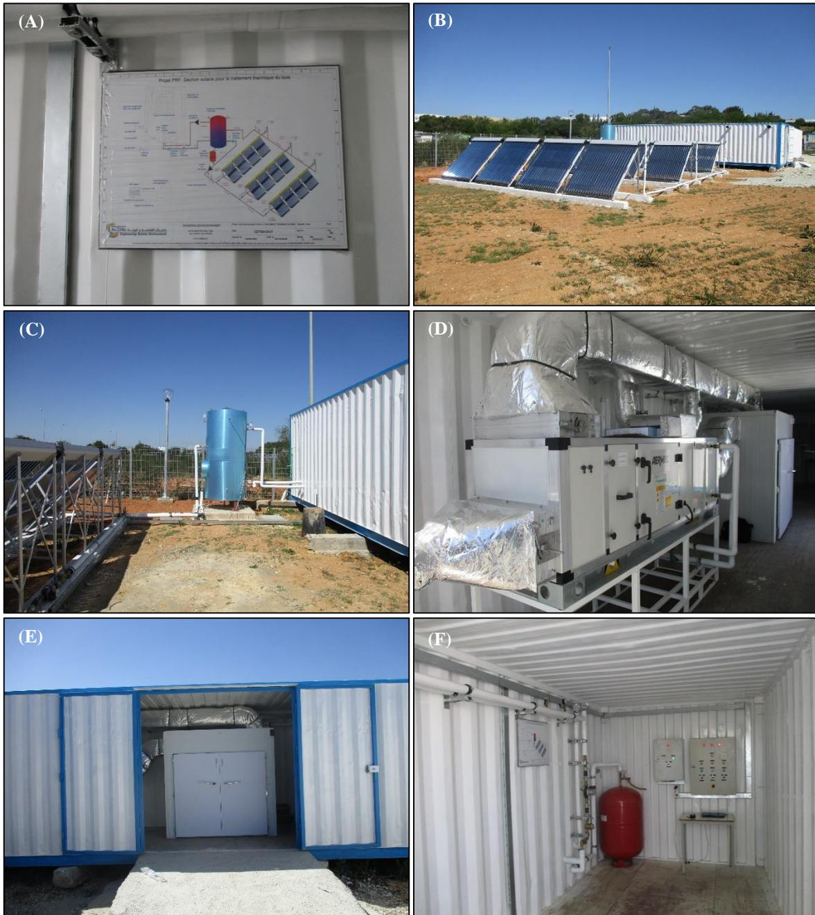
Figure -IV. 3- Prototype de la cellule solaire pour le traitement thermique du bois (A) Schéma synoptique du prototype (B) Le champ solaire (C) Le réservoir de stockage (D) L'unité de traitement de l'air (E) La chambre du traitement phytosanitaire (F) Le vase d'expansion et l'armoire de contrôle
