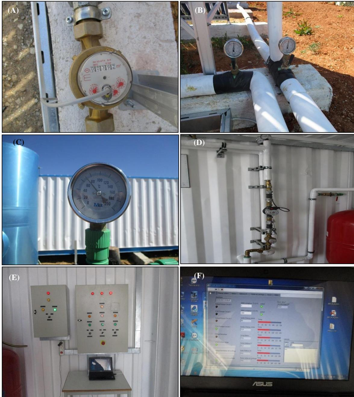
**Figure -IV. 7- Exemples des appareils de mesures et de contrôle (A) Débitmètre (B) Manomètre (C) Thermomètre (D) Ensemble des appareils de mesures pour une conduite (E) Les armoires électriques de contrôle et de commande (F) Le mini PC de contrôle**
