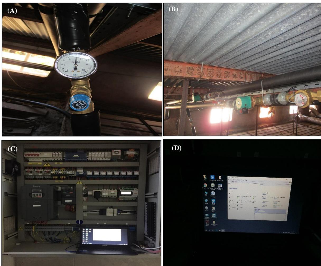
**Figure -VII. 13-Exemples des appareils de mesures et de contrôle (A) Manomètre (B) Ensemble des appareils de mesures pour une conduite (C) Les armoires électriques de contrôle et de commande (D) Le mini PC de contrôle**
