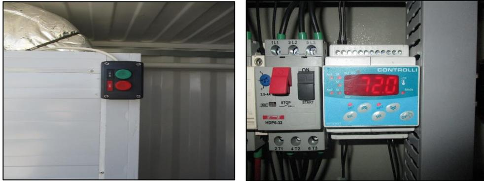
**Figure -IV. 9-Appareils de commande de la cellule (A) Boutons de Marche/Arrêt du circuit d'air (B) Température de consigne de l'air de traitement**
